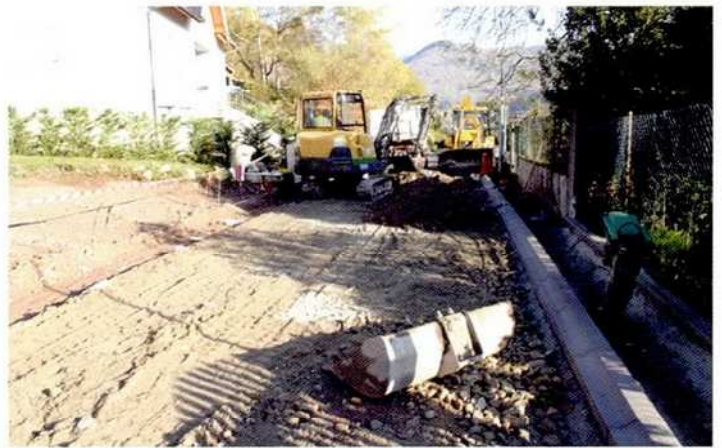
Voirie rue du Burn
