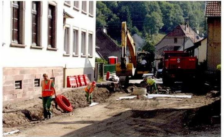
Voirie rue de l'Ecole
