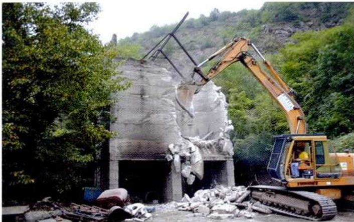
Démolition du silo de l'ancienne carrière (GERPLAN)
