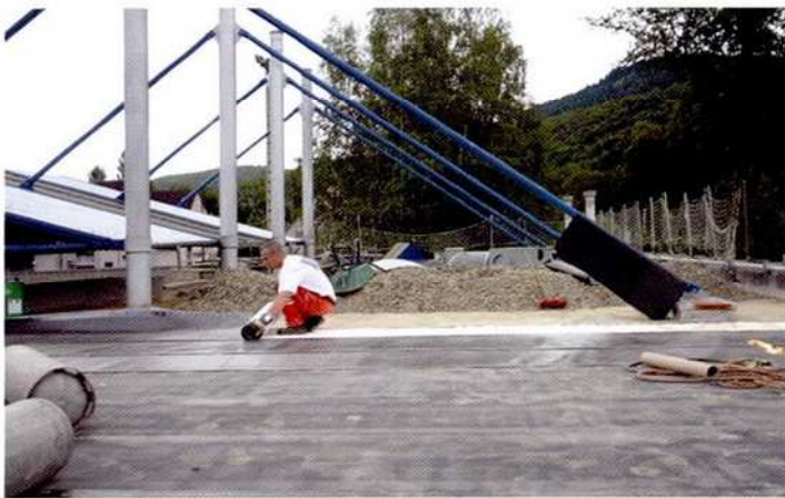
Réfection de l'étanchéité de la toiture des vestiaires du stade
