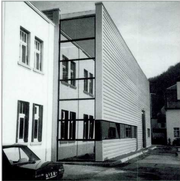
Le nouveau bâtiment en cours de finition
